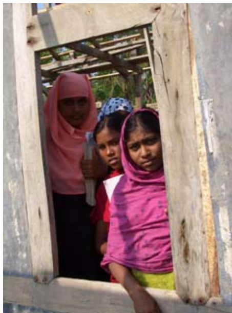
Alcune bambine bangladesi ci guardano incuriosite dallo stipite di una delle finestre della loro scuola distrutta dal ciclone SIDR
